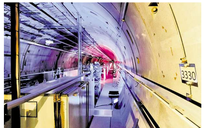
3,4 Kilometer lang: Die Tunnelanlage für den XFEL-Röntgenlaser. FOTO: DPA
